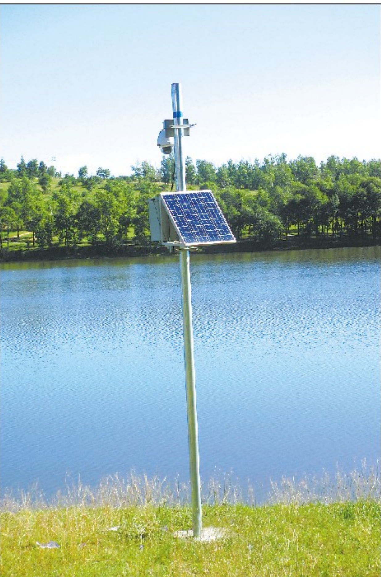
张家口市张北县小二台水库3G视频站
